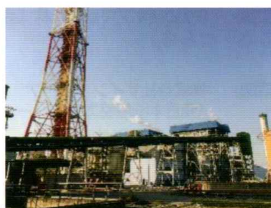
評価を実施した ベトナムの石炭火力発電所
